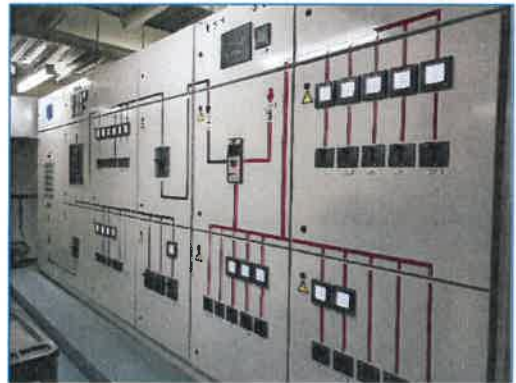
ภาพถ่ายที่ 2.2-15 Circuit Breaker ของโรงแรม
