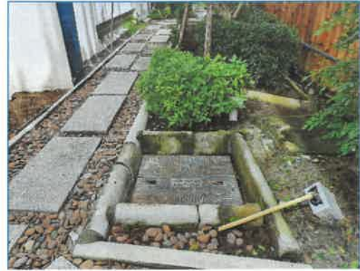
บ่อพักน้ำทิ้งสุดท้าย อาคาร H4
